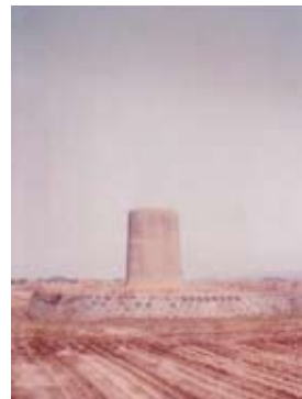
用水機場土曾根口
